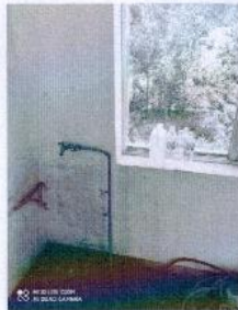
中端采水点(管道采水)
